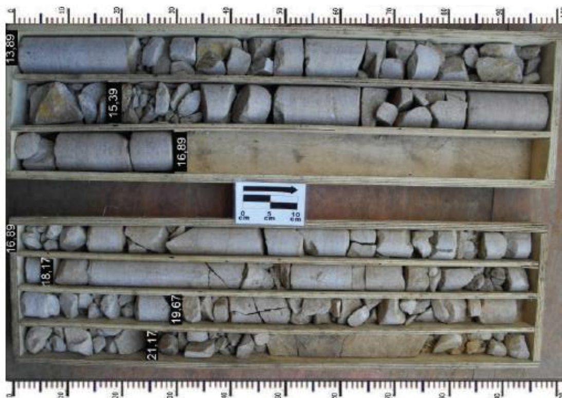
Foto 4.3.11 – A SMB-04 exibe, entre 12,40 e 25,60 m (final do furo), um fraturamento muito intenso, que pode ser atribuído a tectonismo, visto que a sondagem se localiza no fundo do vale, em possível área de interferência de um importante falhamento geológico.
